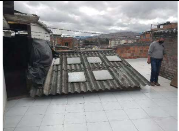
Cubierta patio interior
