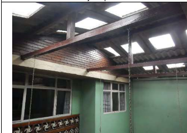
Estructura cubierta patio interior
