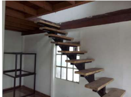
C1: Vista interna
