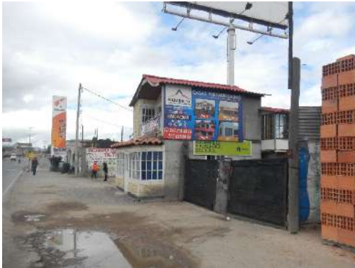
Fachada General - Carrera 4 (Autopista Sur)
