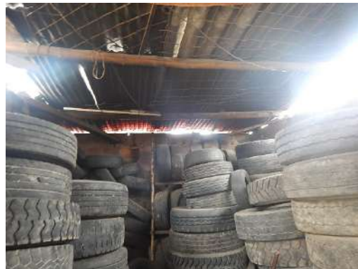
M2: Enramada M3: Muro.
