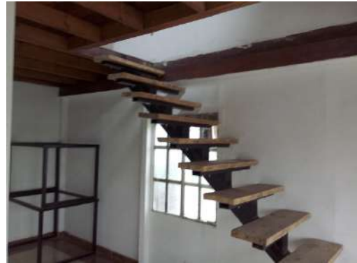
C1: Vista interna
