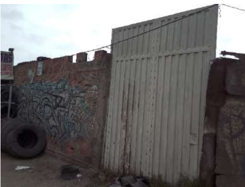
M4: Muro M5: Puerta.
