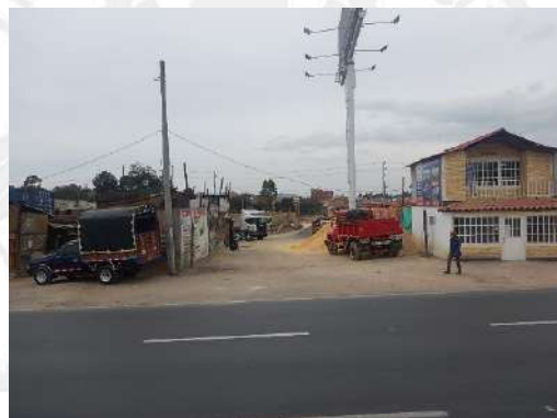
M6: Muro C1: Casa prefabricada.
