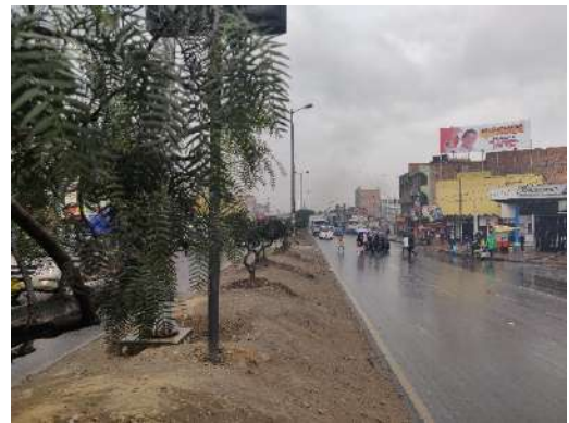
Vista general Carrera 4 (Autopista Sur).
