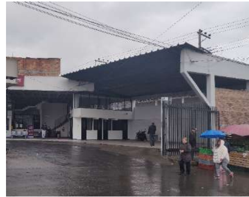
C5: CONSTRUCCIÓN DOS Y TRES PISOS C6: UN PISO TEJA DOBLE ALTURA M2: REJA METALICA
