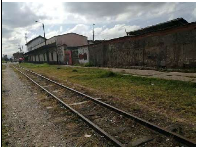
04. Frente Del Predio Sobre El Corredor Férreo
