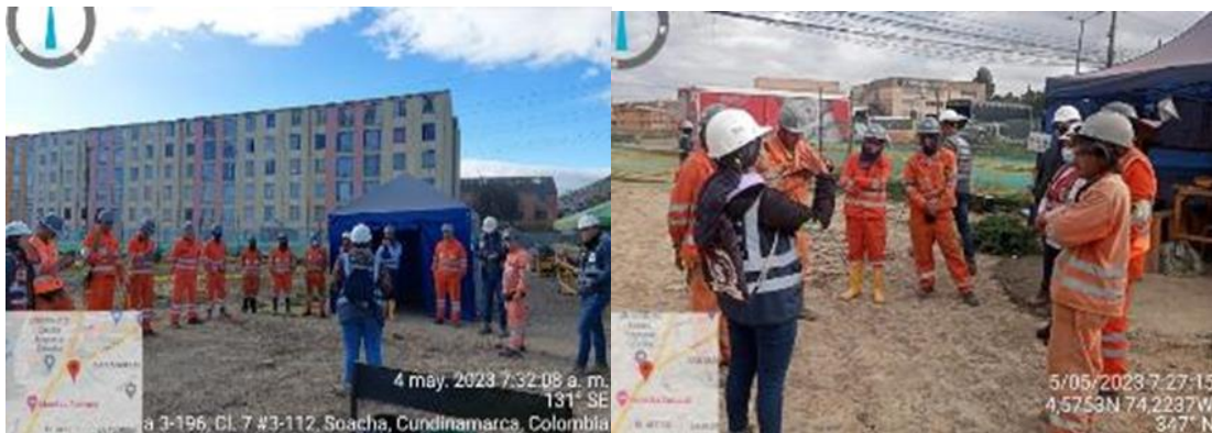
Frente de obra Kra 4 con calle 18
