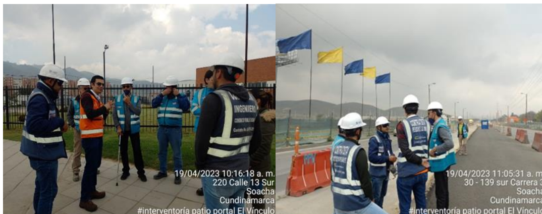
Ilustración 17 Reunión de recorrido información PMT para la Construcción del poste de alta tensión N°4 Enel
